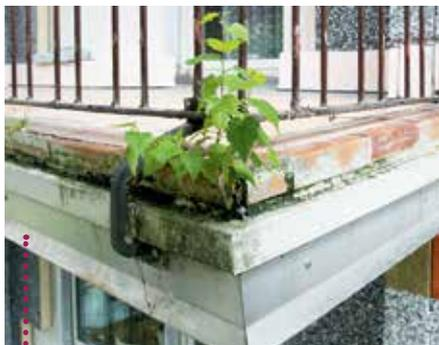
Ohne wirksamen Kantenschutz entstehen früher oder später sichtbare Schäden an der Balkonkonstruktion.
